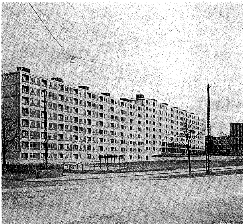
Råhusets teknik, kvalitet og udførelse findes ikke bedre andre steder i verden. Den mest presserende opgave i 60'erne bliver at få færdiggørelsesarbejderne bragt lige så langt og at få kombineret resultaterne fra 50'erne med de brugsmæssige og arkitektoniske synspunkter.
